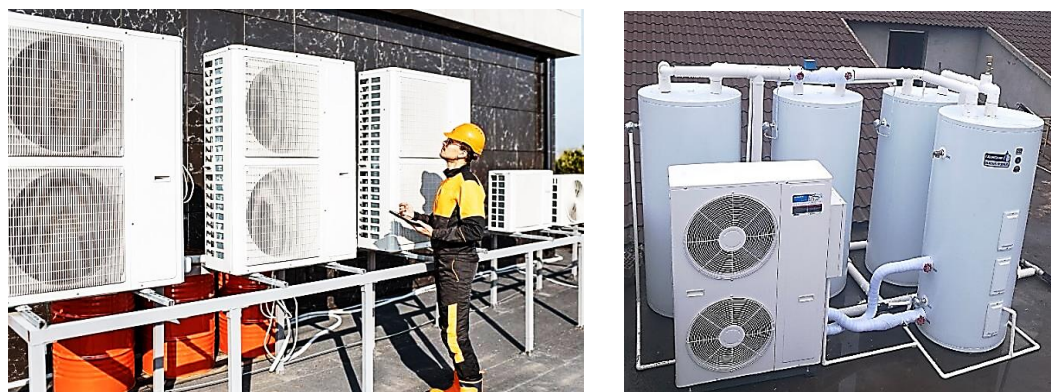
Рисунок 2. Маломощные ТН системы воздух-воздух (слева) и воздух-вода.
