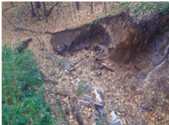
Рисунок 1. Размыв грунта на склоне в районе 1-й улицы Дьяково Городище, вблизи дома 90
